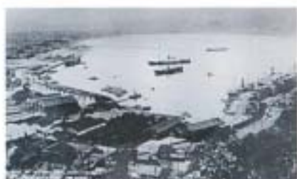
第2期工事完成直前の敦賀港
