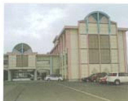
平成9年2月完成した美術棟ともいえる総合学科棟外観
